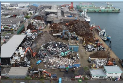
(株)荒川 七ツ島事業所 〔鉄部, 自動車解体部, タイヤ部〕
